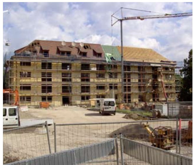
Die Bestandsgebäude der GWG wurden umfassend saniert.
