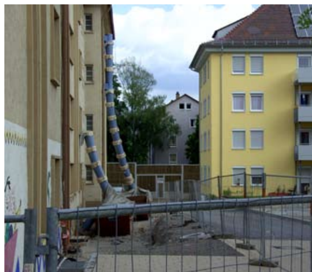
Die Gebäude konnten nur in unbewohntem Zustand saniert werden.
