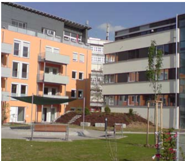
Neben umgebauten Bestandsgebäuden (gelb) entstanden Neubauten.
