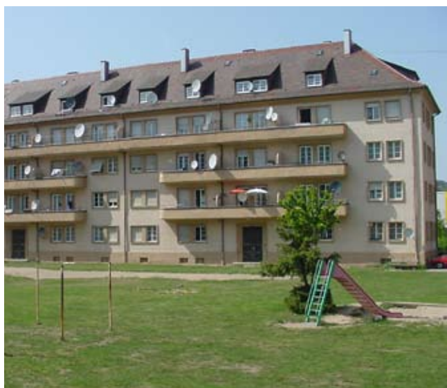
Gebäude und Freiräume in schlechtem Zustand
