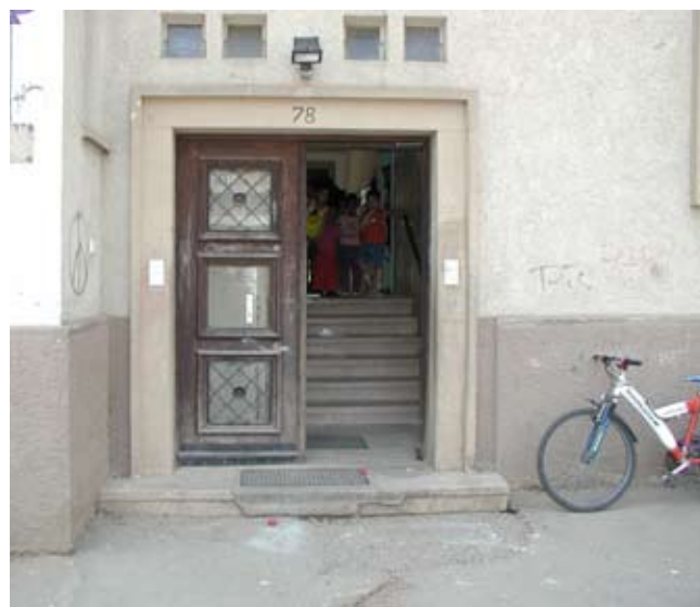
Hauseingänge vor der Sanierung
