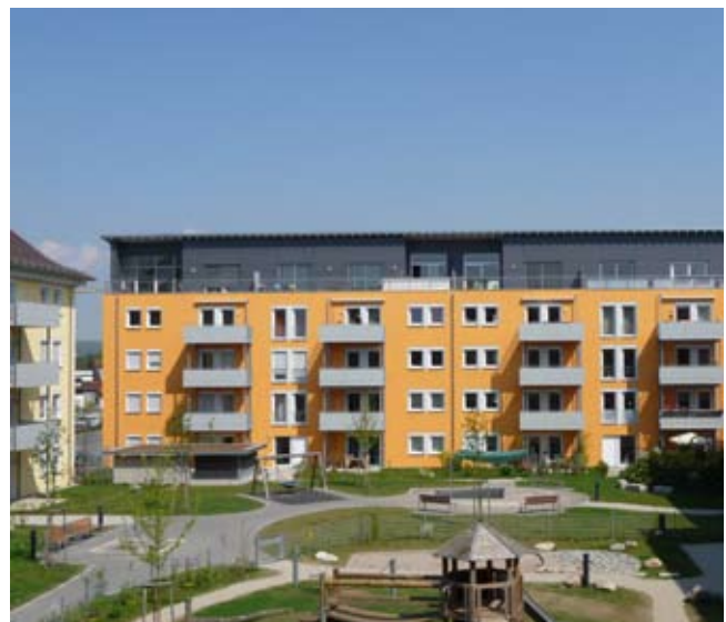
Eine Baugemeinschaft baute das gelbe Bestandsgebäude gemeinsam um.
