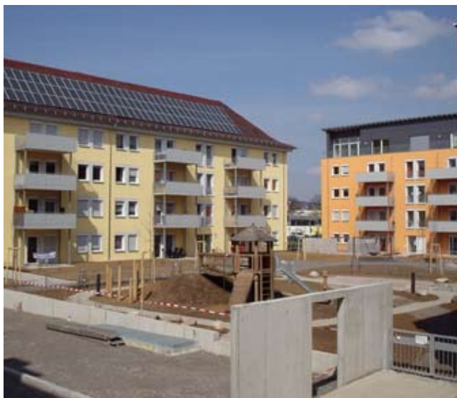
Phase 1 (Hof 3): Bestandsgebäude bereits saniert, neue Carports im Bau
