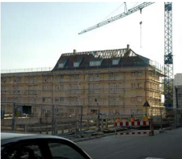
1. Bauabschnitt: Umbau des Gebäudes an der Schweichhardtstraße
