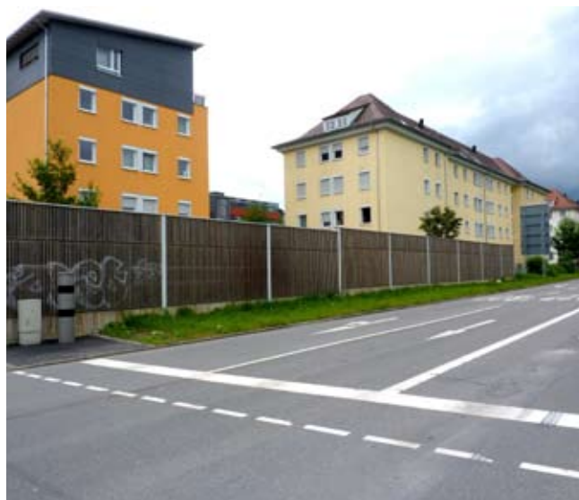
Lärmschutzwände entlang der B27
